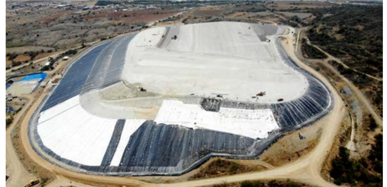
Algunas empresas mineras están realizando la conversión a jales de apilamiento en seco o filtrados. Esta forma de disposición reduce el consumo de agua, pero principalmente reduce significativamente el riesgo de falla del depósito, factor que cobra gran relevancia en zonas de alta sismicidad. Estos métodos de disposición se consideran la mejor tecnología disponible para el almacenamiento de jales.
