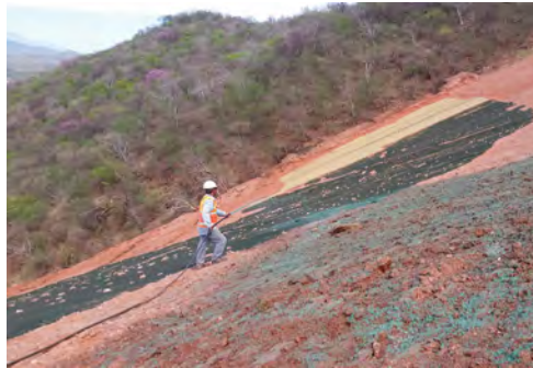
Técnica de hidrosiembra en taludes que consiste en mezclar semillas de pastizales (nativos de la región) con ecofibra adherente y agua.
