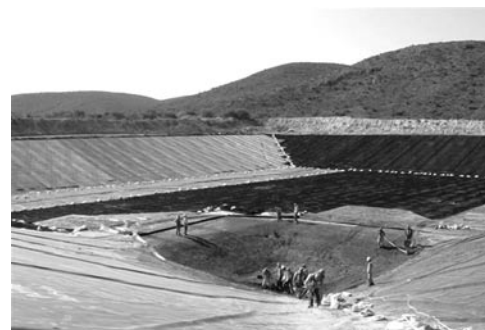
Construcción de la presa de Jales, Minera San Xavier.
